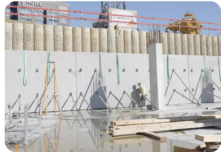
L'Uniwall utilise des éléments de paroi préfabriqués en béton placés devant la paroi de soutènement.
